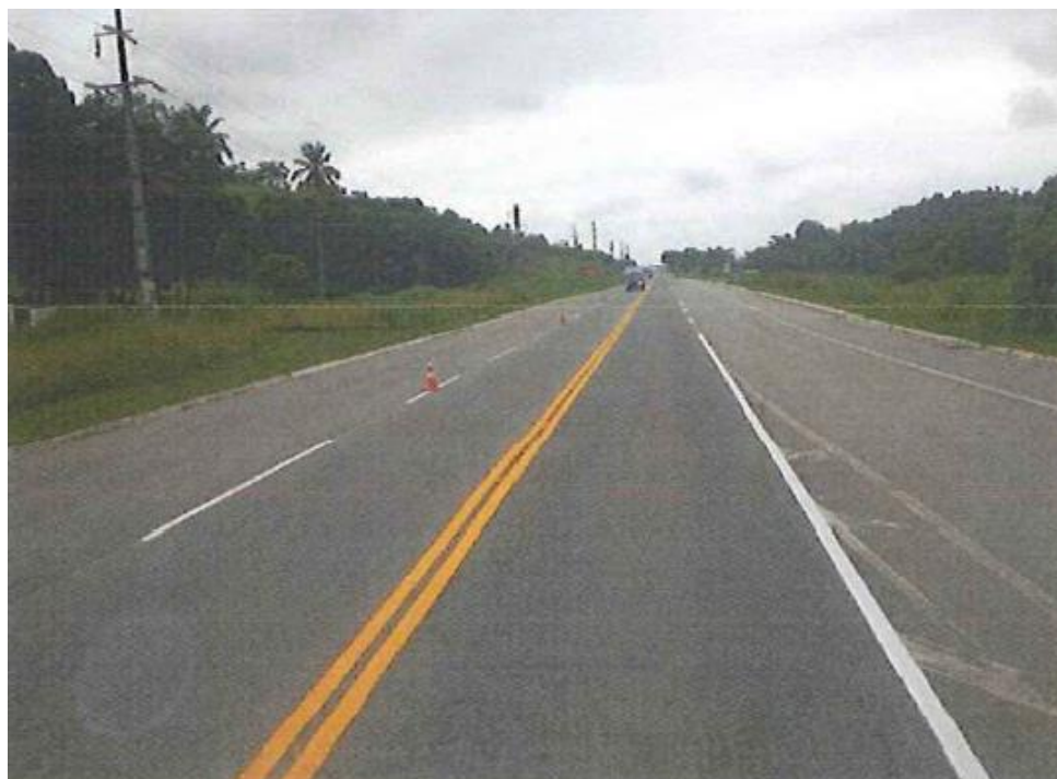
Figura 7 (2) – Repintura de sinalização horizontal. (Fonte: Relatório Técnico Operacional)
