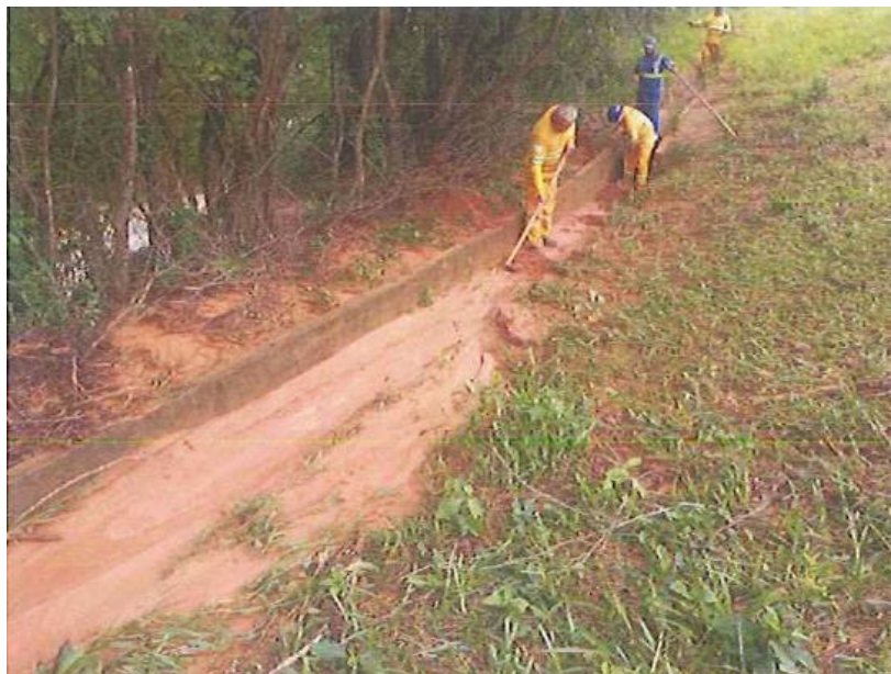
Figura 7 (1) – Limpeza da canaleta. (Fonte: Relatório Técnico Operacional)
